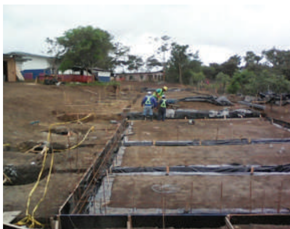
Excavación de fundaciones y Compactación del Concreto – Escuelas Cerro Algodón Proyecto Distrito de Múña 23/6/2016
