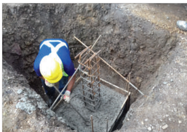
Excavación de fundaciones y Compactación del Concreto – Escuelas Cerro Algodón Proyecto Distrito de Múña 23/6/2016
