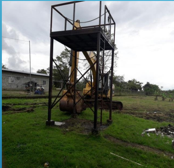
DEMOLICION DE ESTRUCTURA PARA TANQUE DE RESERVA ESCUELA SAN VICENTE.
