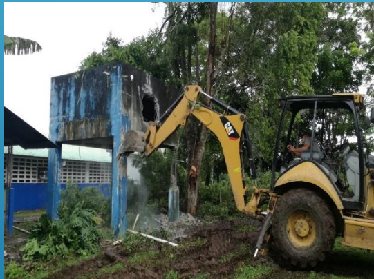
DEMOLICION DE TANQUE DE RESERVA ESCUELA NICANOR
