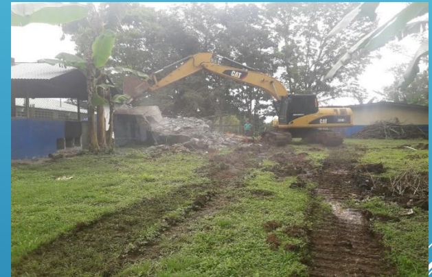
DEMOLICION DE TANQUE DE RESERVA ESCUELA NICANOR
