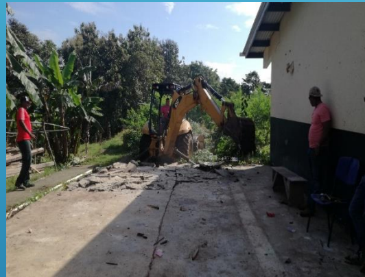
DEMOLICION DE DEPOSITO DE MADERA EN LA ESCUELA CANGON.
