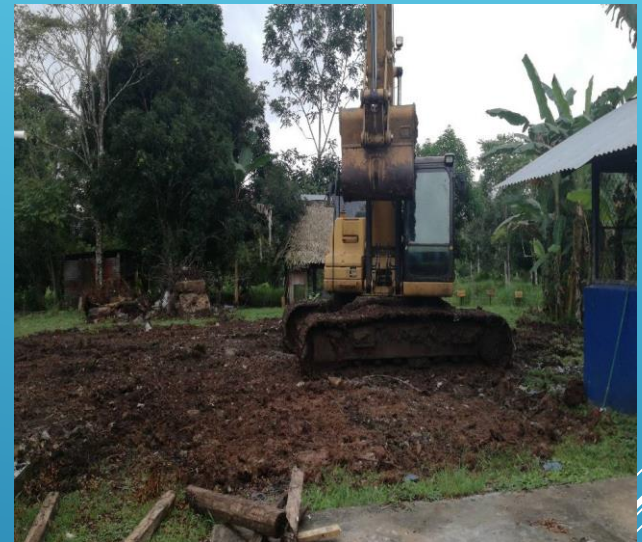
DEMOLICION DE TANQUE DE RESERVA ESCUELA NICANOR
