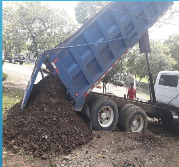
DESCARGA DE TOSCA PARA ENTRADA DE CAMIONES DE MATERIALES.
